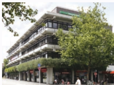
Das Gebäude liegt zentral in der Kaiserstraße 2-4 in unmittelbarer Nähe des Reutlinger Hauptbahnhofs.
